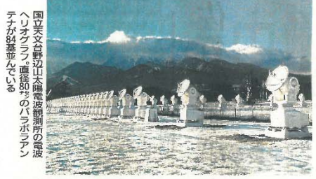
国立天文台野辺山太陽電波観測所の電波ヘリオグラフ。直径80メートルのパラボラアンテナが84基並んでいる
